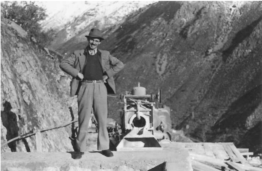
Jorge Insunza Barrios en los años 40, cuando trabajaba en la construcción de la central hidroeléctrica Abanico.
